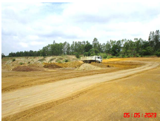
รูปที่ 13 การถมกลับขุมเหมือง
